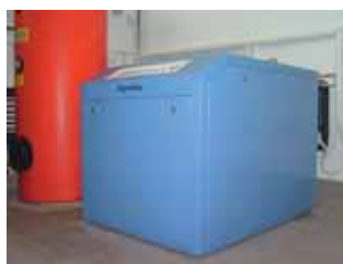
3. ábra. A Vaporline® GBI13-HACW sólé-víz (B/W) hőszivattyú bukaresti beépítése
